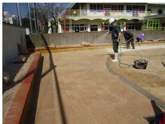
④ 散水作業
