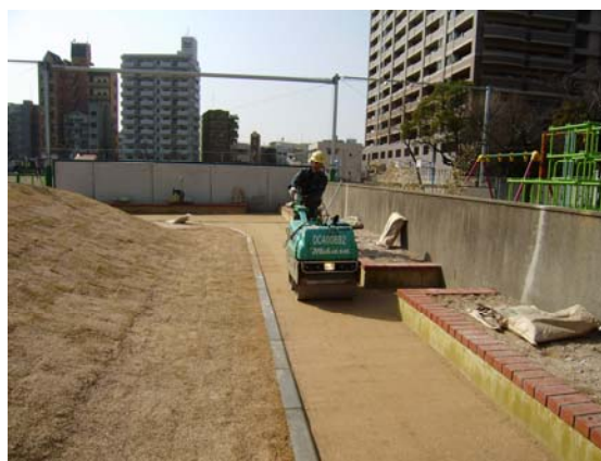
⑤ 転圧作業
