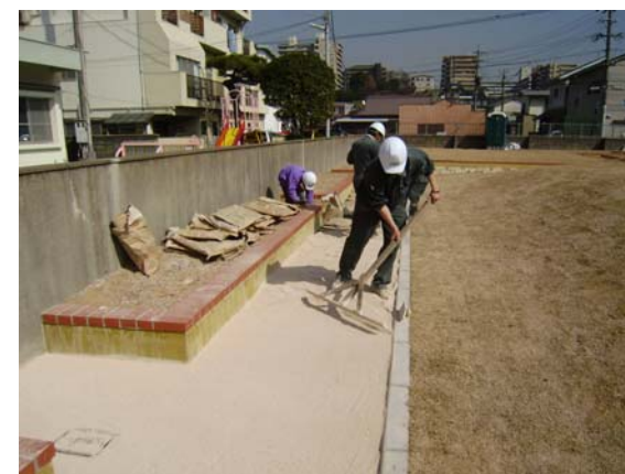
③ 敷均し状況
