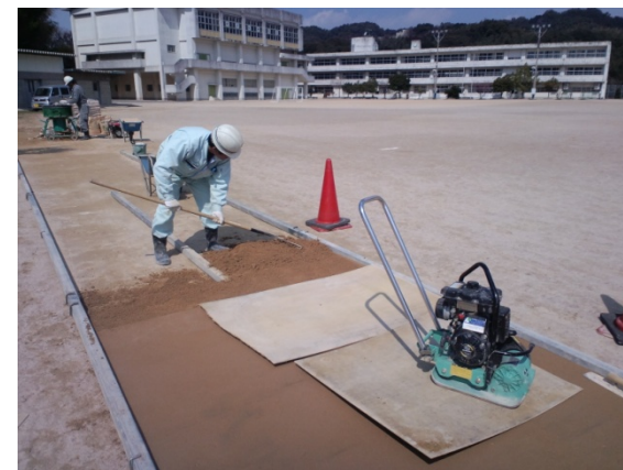
③ 敷均し状況
