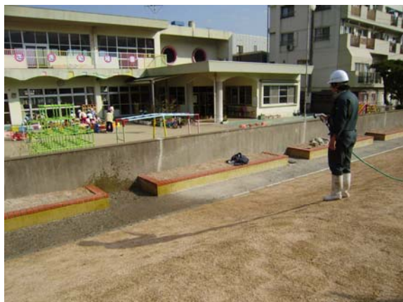
① 下地散水作業
