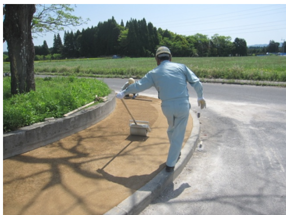
④ 転圧状況
