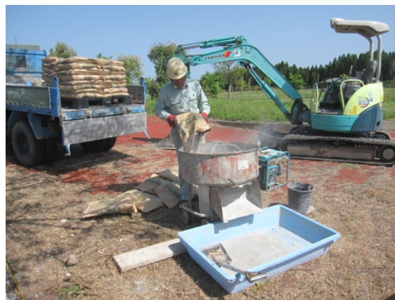
② 加水混合状況
