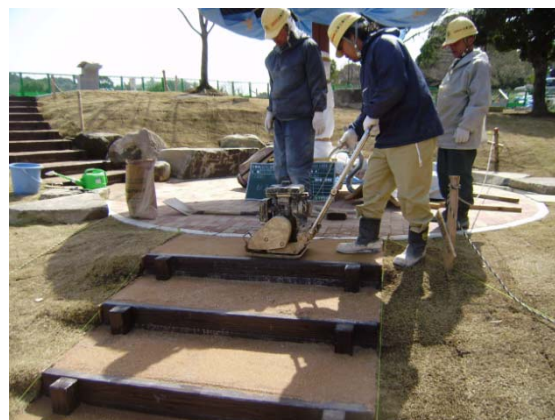
作業中(振動コンパクター転圧)
