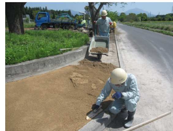
③ 敷均し状況
