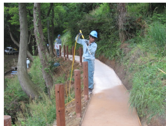
③ 散水状況
