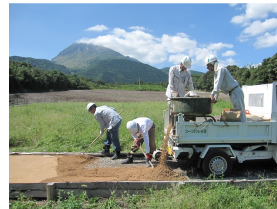
③ 敷均し状況
