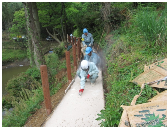
② 敷均し状況
