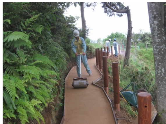
④ ローラー転圧状況
