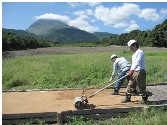
④ ローラー転圧状況
