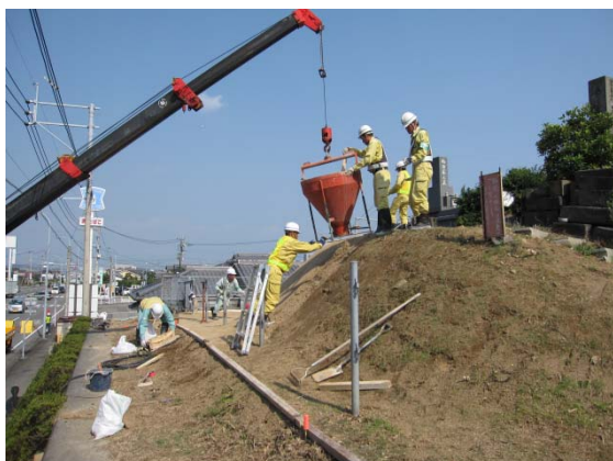
④ 敷き均し
