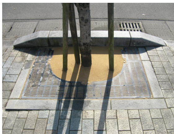
⑤ 幹回り敷均＋散水完了
