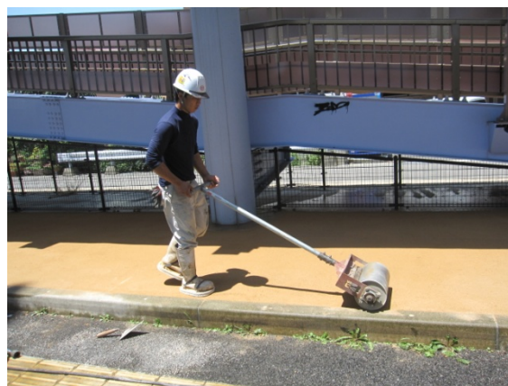
⑤ 転圧作業中
