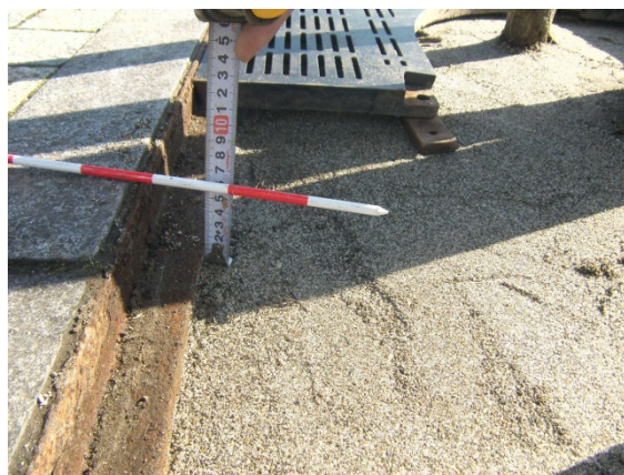
② 除根・下地処理完了
