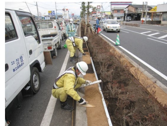
③ 敷き均し作業中
