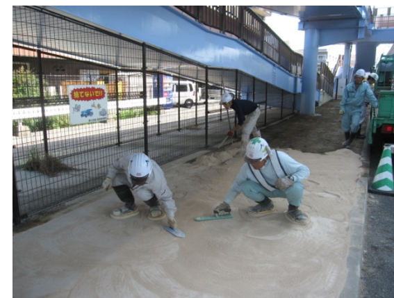
③ 敷き均し作業中
