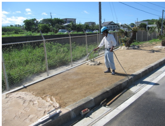
② 下地散水作業中
