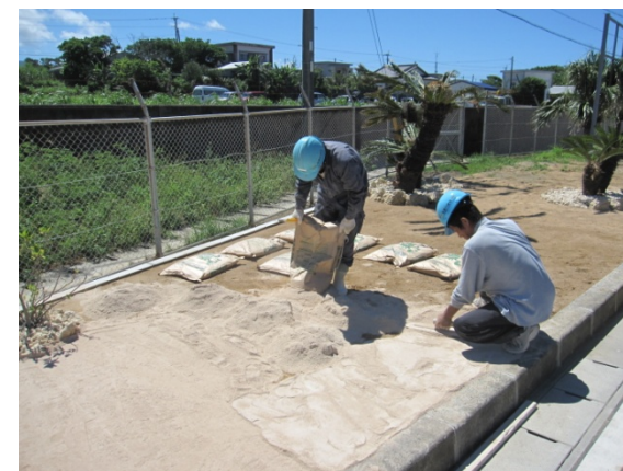
③ 敷き均し作業中
