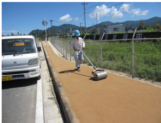
⑤ 転圧作業中
