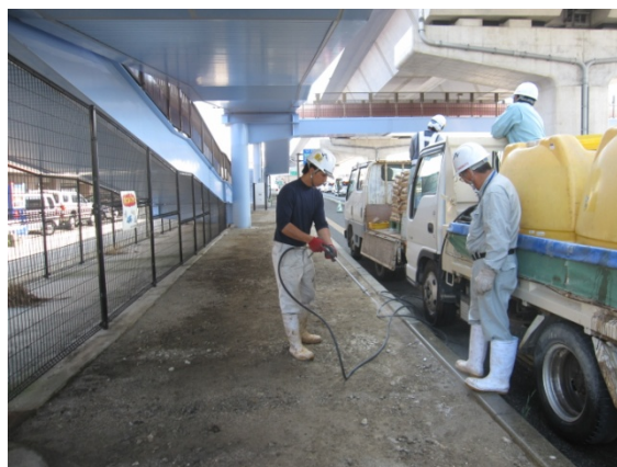
② 下地散水作業中
